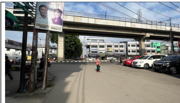
Gambar (1) Kondisi Jalan Menuju Simpang Jl. Jend. Sudirman
