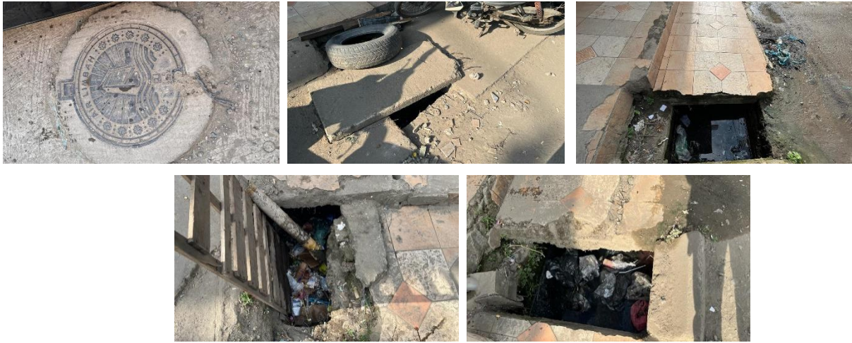
Gambar 4-5 Kondisi Drainase di Sepanjang Kawasan Koridor Jalan Rustam Effendi
