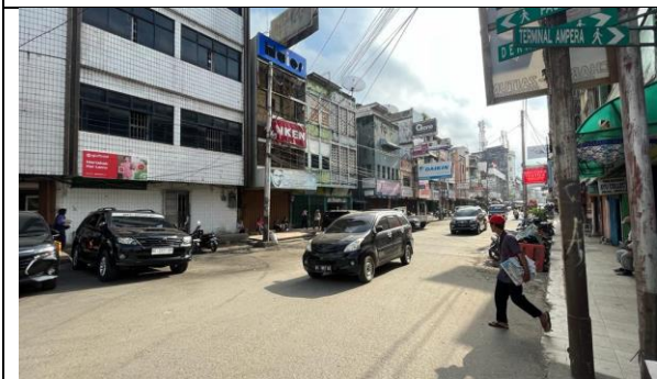
Gambar (7) Kondisi Jalan Rustam Effendi
